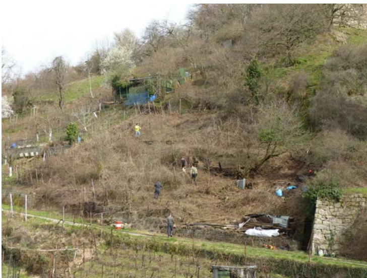
Foto 1400323: Die geräumte Fläche am Ende des Arbeitseinsatzes (Quelle: Projektmanagement)
